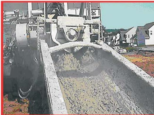
El hormigón sale del transportador del bisenfín y entra en el canal de descarga
