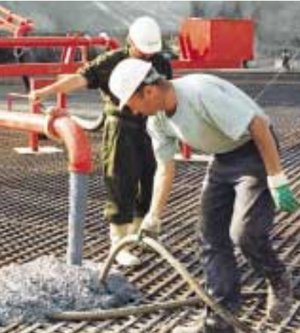
Distribuidor redondo RV 10 para la distribución fácil del hormigón
