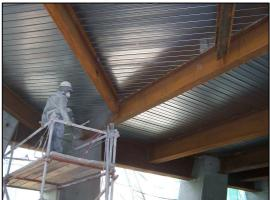
bombas helicoidales no funcionaban bien con el mortero utilizado y siempre daban fallos. La selección se restringió rápidamente a bombas helicoidales universales del modelo S5 EV de Putzmeister. Tras una breve fase Nr.: 0012-07
